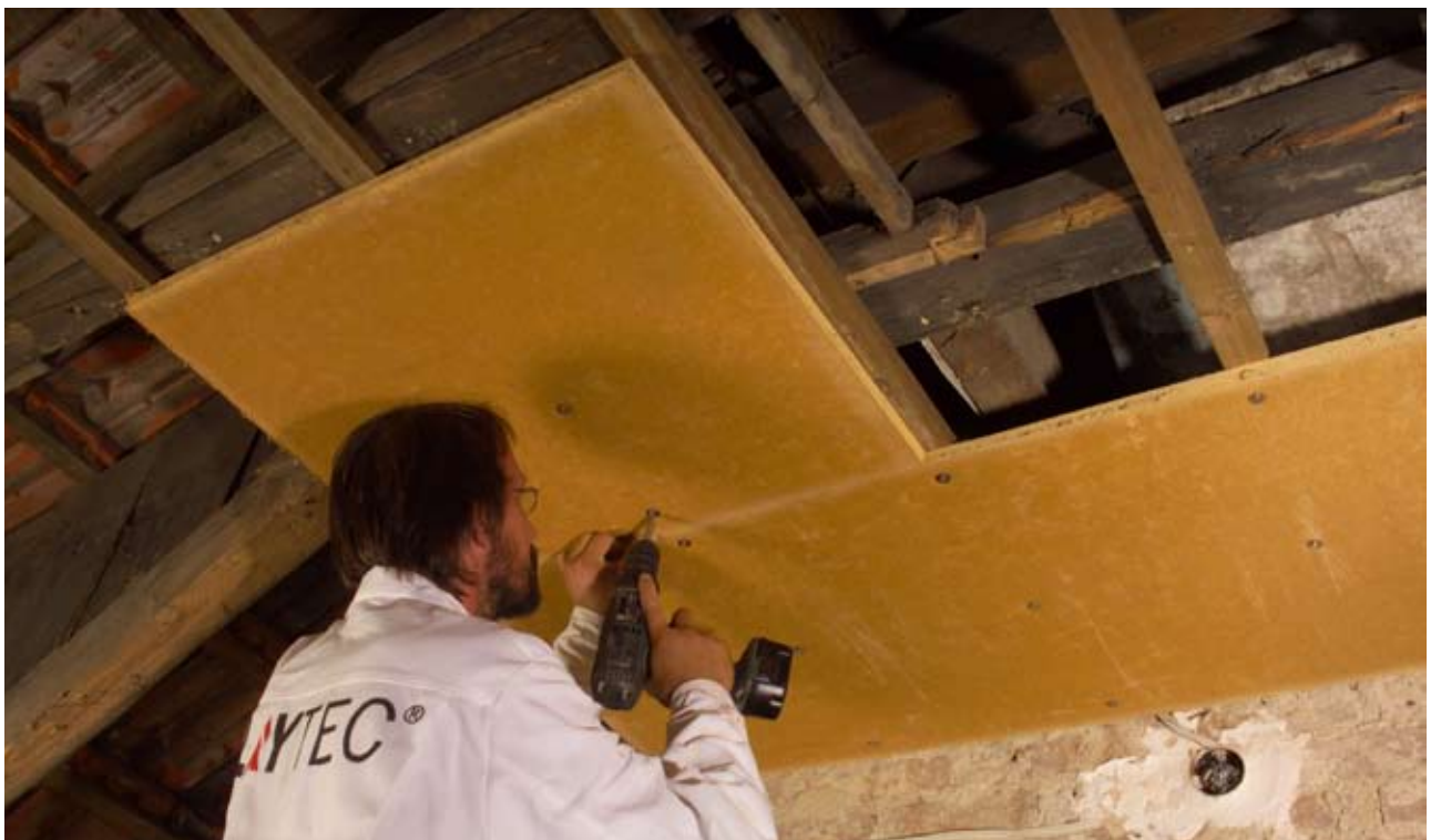
Abbildung 5.2.3: Befestigung der Lehmbauplatte an der Verlattung einer Unterdecke
