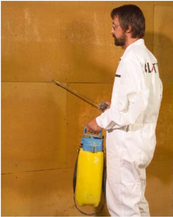
Abbildung 5.2.4: Vornässen der Fugenbereiche der Lehm- bauplatten
