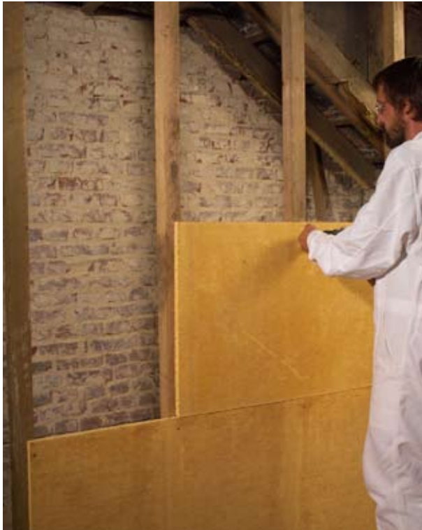
Abbildung 5.2.1: Montage der Lehmbauplatten am Pfostenwerk einer Ständerwand/ Vorsatzschale
