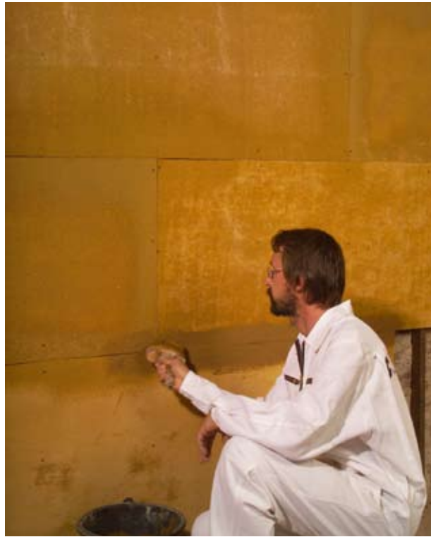
Abbildung 5.2.5: Vorziehen der Schlämme aus Claytec Lehm-Oberputz fein
