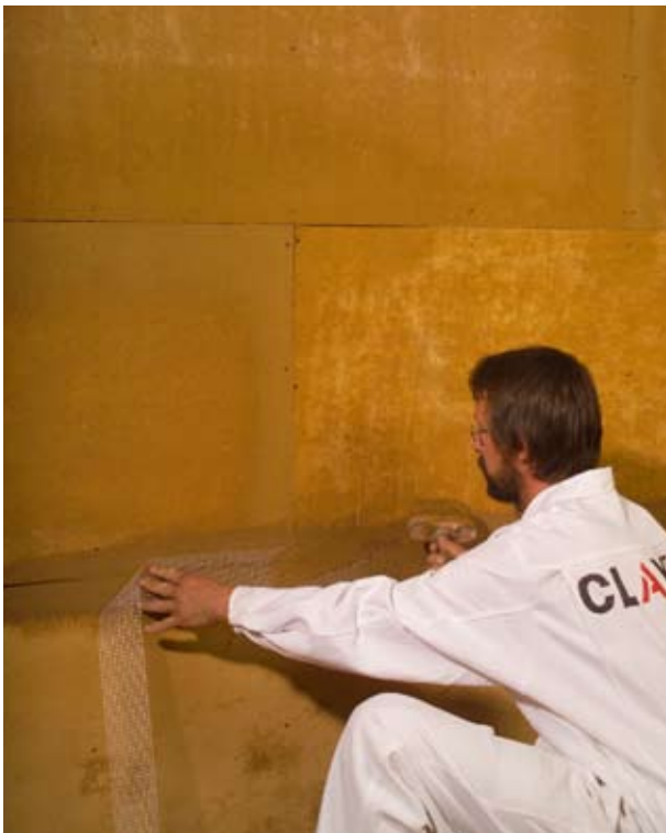
Abbildung 5.2.6: Einarbeiten der Fugenarmierung, hier Glasseidengewebe
