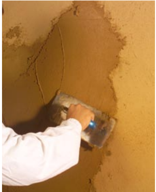
Abbildung 6.1.6: Auftrag von Lehm-Oberputz fein mit dem Edelstahlglätter, Auftragsstärke ca. 3 mm
